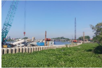
CỌC VÁN KÈ BẠCH ĐĂNG BACH DANG EMBANKMENT
