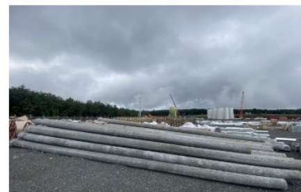
NHÀ MÁY ĐIỆN GIÓ ĐẮK LẮK DAK LAK WIND POWER PLANT
