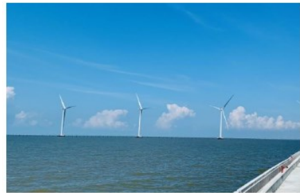
NHÀ MÁY ĐIỆN GIÓ HOÀ BÌNH 2 HOA BINH 2 WIND POWER PLANT
