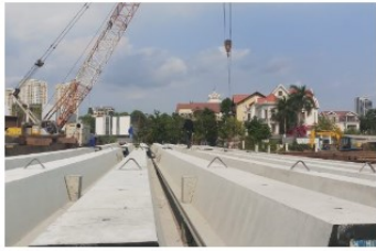
BỜ KÈ TẢ SÀI GÒN SAI GON EMBANKMENT
