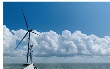
NHÀ MÁY ĐIỆN GIÓ HÒA BÌNH 1 HOA BINH 1 WIND POWER PLANT
