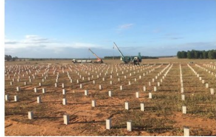
ĐIỆN MẶT TRỜI TÂY NINH TAY NINH SOLAR POWER PLANT
